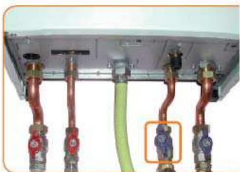
**Примечание:** Во избежание исчезновения давления при заполнении котла, когда прекращается водоснабжение, а также произвольного включения аппарата на ГВС при скачках давления в водопроводе необходимо установить обратный клапан на входе холодной воды.
