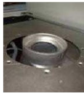
Для аппаратов 24 кВт и 28 кВт используются разные типы диафрагм .
